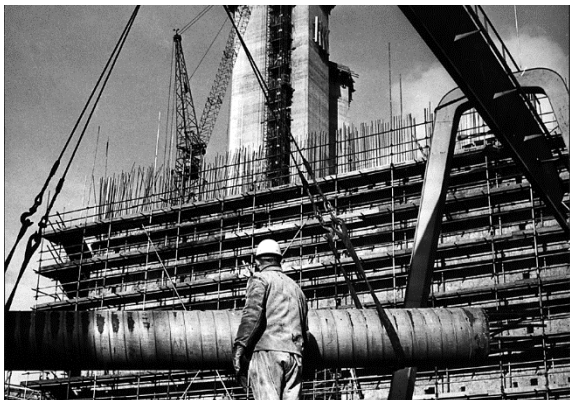
Bau der Stadthalle zu Beginn der 70er Jahre. Foto: C 3 GmbH
